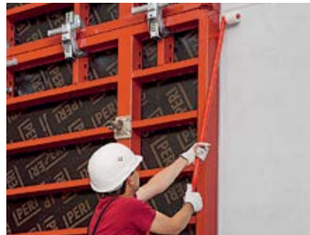
Используя монтажку, панели можно отделить от бетона легко и без повреждений. Направляющий ролик также предотвращает повреждение бетонной стены.
