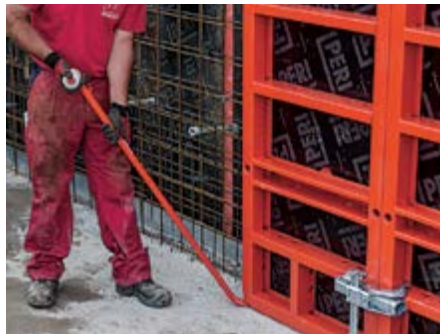
С помощью фаски на углу рамы TRIO MR можно выровнять панели.
