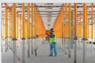
Опалубка для перекрытий
