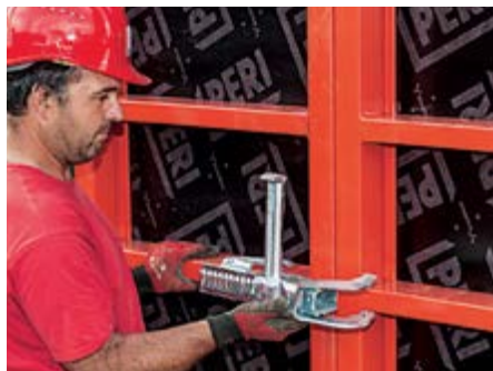
Выпрямляющий замок BFD можно монтировать одной рукой.
