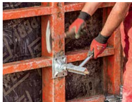
С помощью ключа для тяжей все операции выполняются одним монтажником.
