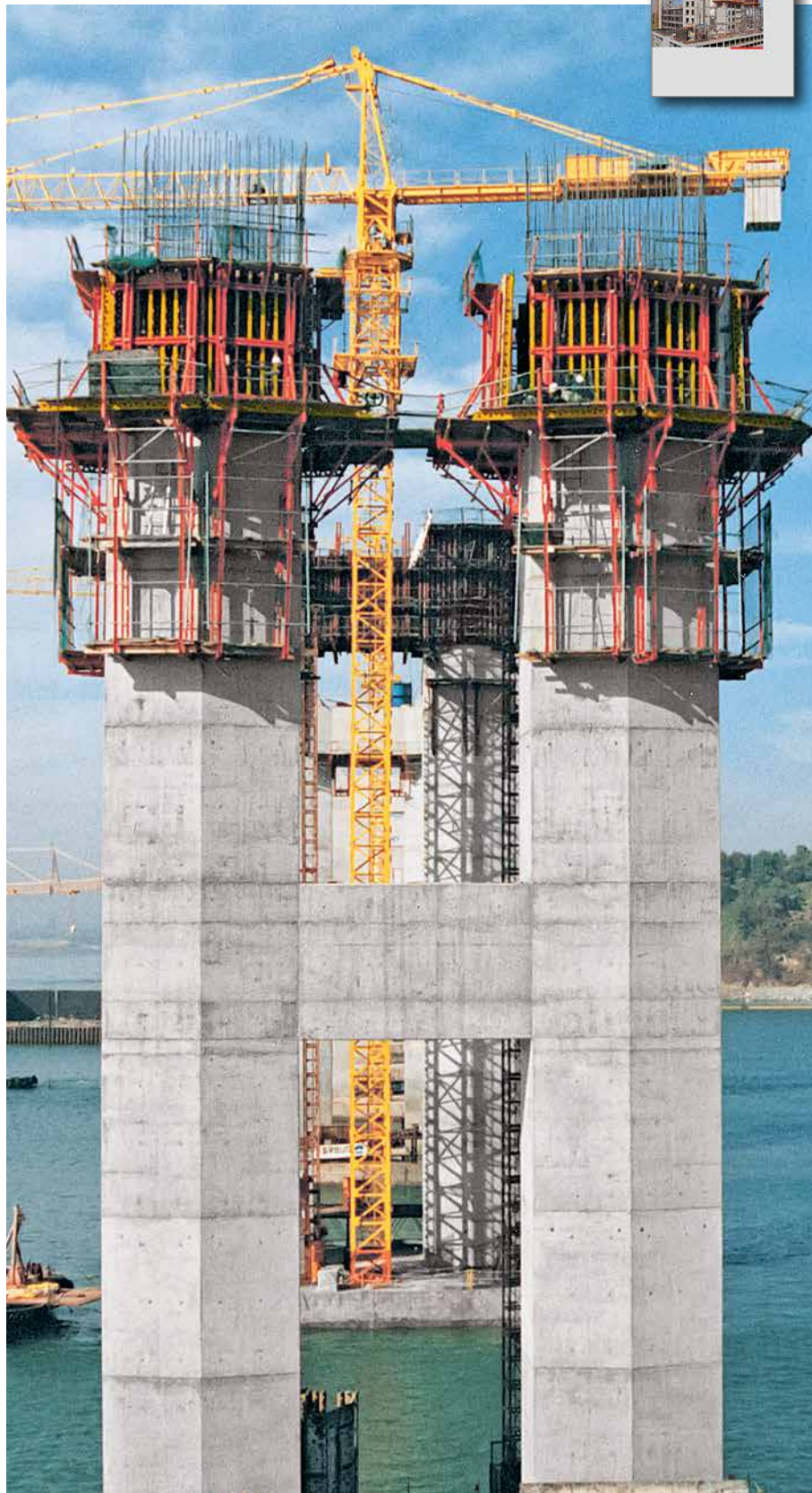
Треугольная консоль СВ 240, для работы перед и за опалубкой.
