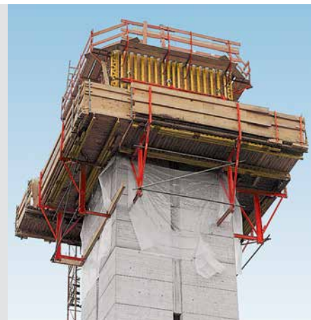
Колокольня в Фелдмохинге, недалеко от Мюнхена. VARIO GT 24 на подъемно-переставных консольных лесах KGF 240.
