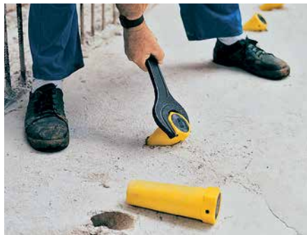
Демонтаж муфта-фиксатора с помощью гаечного ключа SW 70.
