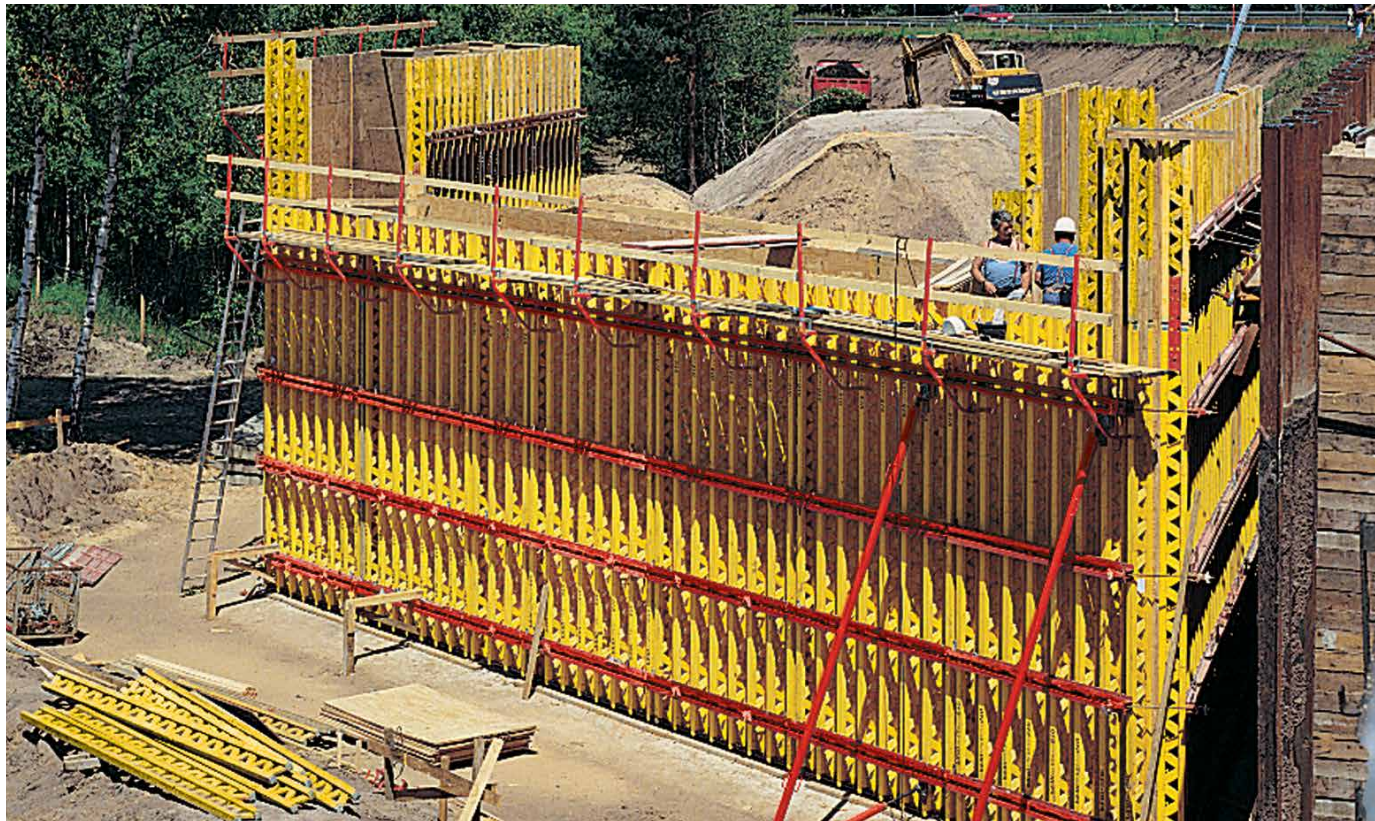
Мост через Дунай, Автострада BAB 8, недалеко от г. Лайпхайм.
