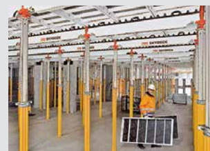
Опалубка для перекрытий
